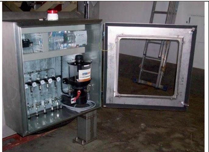
Existen varios tipos de sistemas de lubricación centralizada para una central. El tipo más común es el sistema de circulación de aceite, como este de InterLube.
