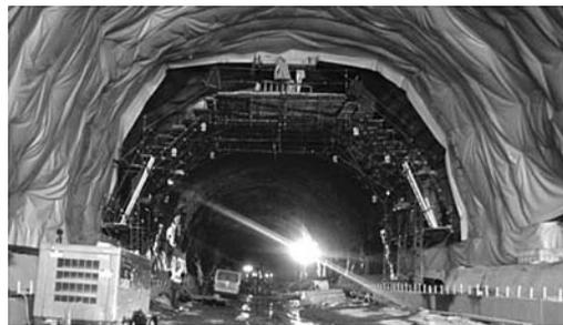
Figura 4: Colocación de un geotextil de separación
