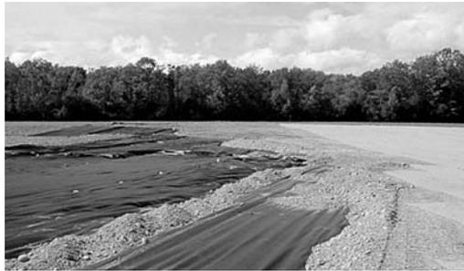
Figura 3: Geotextiles para impermeabilización
