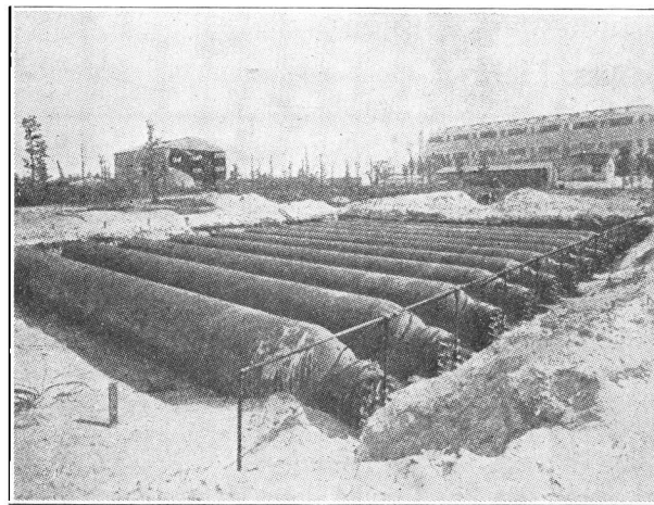
Figura 5.—Almacenamiento a alta presión del helio en Lakehurst, antes de la cubrición.
